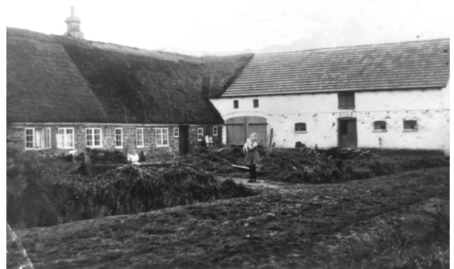
Mandø Byvej 24 var et eksempel på et traditionelt længehus (senere nedrevet, foto ca. starten af 1900-tallet), hvor der i slutningen af 1800-tallet blev tilføjet en trempellade direkte på den gamle længe. Muligvis er der bygget videre på dele fra en ældre staldbygning. Trempelladen fremstår med en høj hvidkalket facade, tag i naturskifer, et lille udhæng med synlige spærender, murede sålbænke enkelte steder og en gesims ved etageskiftet. Bygningen fremstår med revleluger, -døre og -porte samt smedejernsvinduer og 1800-tallets karakteristiske støbejernsvinduer (se bygningsbegreber del 2 s. xx).
