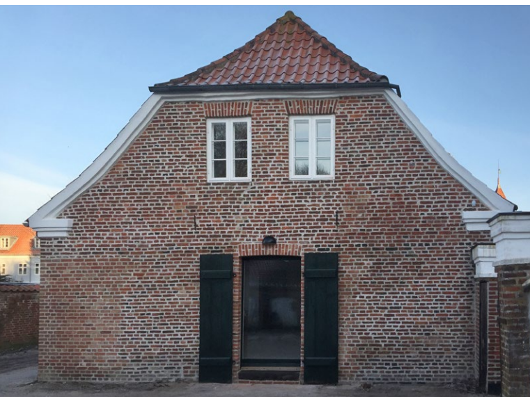
Eksempel på forsatsdør placeret på bagsiden af døråbningen ved en revledør (Bispegade 6, Ribe). Revledøren er nænsomt bevaret, kan uden problem stå åben og bidrager med karakter og autenticitet til bygningen. Den nye dør åbner indad og er energirigtig i forhold til nutidige krav.
