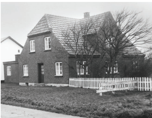
Mandø Byvej 24 (opført 1939, foto 1979) er et godt eksempel på en muremestervilla. Huset er velproportioneret med en centreret gavlkvist, taget er halvvalmet, opskalket og tækket med tegl. Tagfladen brydes kun af en muret skorsten, og facaden fremstår i blankt murværk. Vinduerne er malet hvide, og døren er malet i en mørk nuance. Det er anvendt en vinduestype med tre ruder i hver ramme, sprosser og kitfals, som også kan ses ved både de traditionelle og nyere længehuse. På dette hus anvendes den traditionelle ramme både i to, tre og fire fag.
