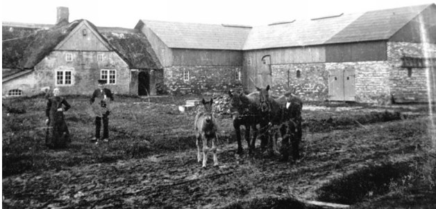
Billedet fra Midtvej 6 (foto ca. starten af 1900-tallet) fortæller om en tydelig udviklingshistorie, hvor der er blevet bygget til efter behov. Trempelladen er sandsynligvis startet som en tilbygning i traditionel byggeskik. I slutningen af 1800-tallet har man forhøjet stald/lade med en trempelkonstruktion, hvor man har anvendt bræddebeklædning i trempelstykket over murstenene. Trempelladen fremstår med store revleporte, enkelte støbejernsvinduer og et naturskifer tag med et forholdsvist stort udhæng. På tagfladen ses tre lave tagryttere.
