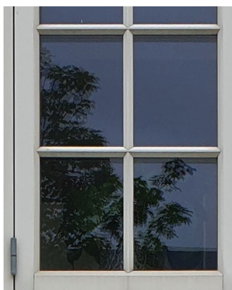
Eksempel på et plastikvindue med tolagsglas og termoruder. Sprosserne er udformet spinkelt og med en trekantsliste, hvilket bidrager med en lethed til vinduet. Dog har glasset en plan og mørk overflade, hvor omgivelserne og sprosserne spejles dobbelt på grund af de to lag glas. Både glasset og plastikoverfladen giver facaden et ensformigt udtryk sammenlignet med et kittet trævindue malet med linoliemaling.
