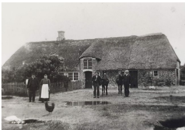
Mandø Kirkevej 1 (opført 1740, foto ca. 1900) blev opført som et typisk traditionelt længehus. Huset bestod af en længe med bolig og stald under samme tag. Oprindeligt fremstod det med blank mur, røde tegl, hvidtede fuger, stråtag, halvvalm, skorsten i tagryggen, vinduer placeret flugtende med facaden, en arkengaf med høgab og enkle revledøre malet i mørke nuancer. Vinduerne var torammede med ni ruder i hver ramme (hvilket er ganske unikt) og de murede stik er markeret med en tofarvet bemaling. Huset har gennem tiden gennemgået mange forandringer, men en del elementer er stadig bevaret.
