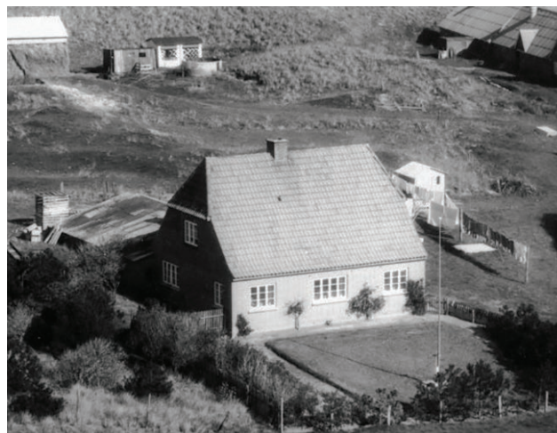
Vestervej 29 (opført 1938, foto 1948) er et godt eksempel på en muremestervilla. Huset er velproportioneret og enkelt, taget er halvvalmet, opskalket og med tegltag. Tagfladen brydes kun af en muret skorsten og facaden fremstår i blankt murværk. Huset fremstår med hvidmalede vinduer med tre ruder i hver ramme, sprosser og kitfals. Denne type anvendes også på de traditionelle og nyere længehuse. På dette hus anvendes den traditionelle ramme både i to, tre og fire fag.
