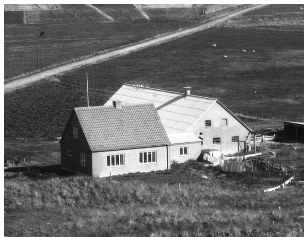
Annelbankevej 4 (opført 1954, foto 1948) er et af de yngste huse i denne kategori. Det er opført med blankt murværk, opskalket tegltag uden udhæng og en enkel skorsten i tagryggen. Huset er generelt mere forenklet end de ældre huse i denne kategori. I stedet for halvvalm fremstår bygningen med helgavl. Vinduerne fremstår ligeledes enkle med fire rammer og store ruder
