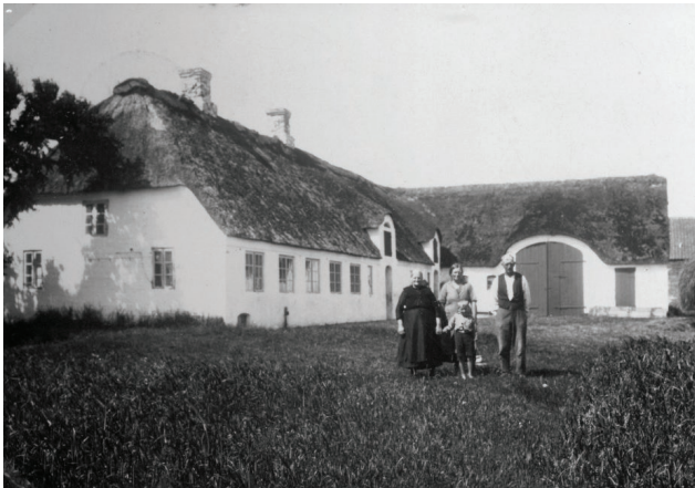
Mandø Byvej 34 (opført 1850, foto omkring 1900-tallet) fremstår her som et godt eksempel på det traditionelle længehus udvidet til to længer, som sammen danner en L-form. På billedet er huset blevet pudset og kalket, men oprindeligt fremstod det muligvis med blank mur i røde tegl og hvidtede fuger. Huset havde stråtag, halvvalm, to skorstene i tagryggen, vinduer placeret flugtende med facaden, to arkengaf med høgab, tagskægskvist over revleporten. Vinduerne var torammede med tre-seks ruder i hver ramme. Huset er senere ombygget, men flere dele er bevaret.
