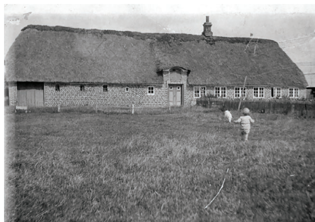
Mandø Byvej 24 (opført i 1700-tallet, foto ca. 1900-tallet) blev ligeledes opført som et typisk traditionelt længehus med bolig og stald under samme tag. Oprindeligt fremstod det med blank mur, røde tegl, hvidtede fuger, stråtag, halvvalm, skorsten i tagryggen, vinduer placeret flugtende med facaden, en arkengaf med høgab og en tofarvet dobbeltfløjet fyldnings- eller revledør. Vinduerne var torammede med seks ruder i hver ramme. Huset er senere ombygget, men flere dele er bevaret.
