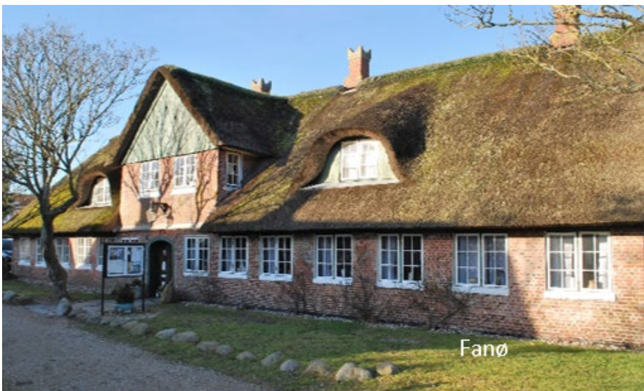
Nogle af de større skippergårde på Fanø har store gavlkviste, voluminøse tagkviste og dekorerede skorstene.
