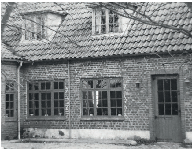
Mandø Byvej 26, Mandø Kro (opført 1900, foto 1979) er et eksempel med mange forskellige vinduer fra forskellige tider. Her ses vinduer fra starten af 1900-tallet med et til tre fag, overramme, sprosser og kitfals. Vinduerne er maalede i en mørk nuance, udført med ruder i cylinderglas (se s. xx), tophængte overrammer og sålbænke i teglsten. Over vinduerne ses en tegloverligger. Døren er en form for revledør med et øvre parti af ruder og sprosser. Døren synes at have samme nuance som vinduerne, og døråbningen har en nyere muret indfatning.
