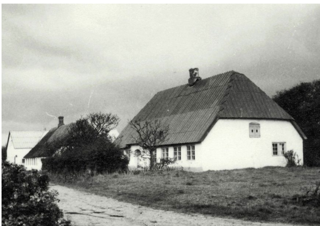
Mandø Kirkevej 3 (opført 1777, foto ca. slutningen af 1800-tallet) er et af de ældste længehuse på Mandø. Bygningen indeholdt kun bolig og høløft og fremstod både kortere og bredere end sine nabobygninger, men ligesom de øvrige traditionelle længehuse havde bygningen en lav facadehøjde. Huset havde små torammede vinduer med sprosser og seks ruder i hver ramme. Revlelugen fremstod enkel, lille og med små glug. Døren var placeret ved en lille arkengaf, og gesimsen var udformet helt enkelt. Skorstenen afslører, at huset højst sandsynligt er opført i blank mur og senere er blevet kalket hvidt. Huset var oprindeligt opført med stråtag, som senere blev udskiftet med pandeplader. Huset har gennemgået mange forandringer, men en del elementer er stadig bevaret.
