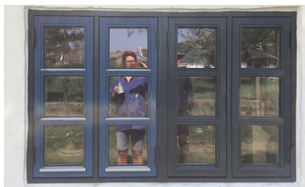
Eksempel på, hvordan maling af alulister og hængsler i samme farve som vinduerne kan skabe et mere ensartet og roligt udtryk. Til venstre ses den del af vinduet som endnu ikke er malet og til højre ses den del af vinduet som er blevet malet. Privat foto, Mandø Byvej 17.
