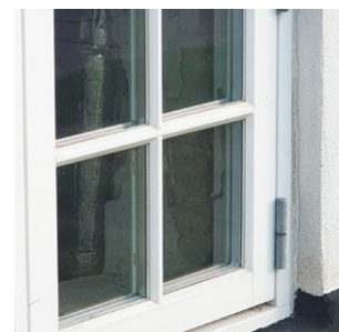
Eksempel på et nyere vindue med sprosser samt termoruder med tolagsglas. Aluminiumslisten mellem glassene får sprossen til at fremstå dyb, og vinduet opnår derfor ikke den samme lethed som et traditionelt vindue.
