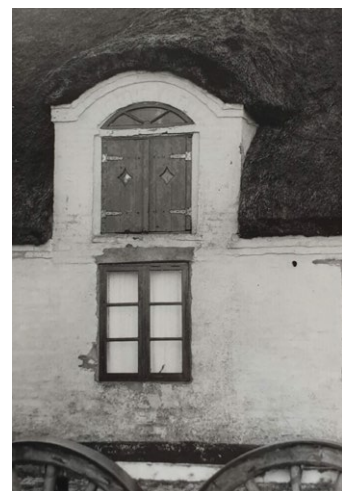
Bolengvej 2 (opført 1800, foto 1979) fremstod med revleluge med rudeformede glug og stabelhængsler fastgjort på karmen. Over revlelugen ses et tredelt kittet trævindue med buet form, som følger arkengaffets murede stik.
