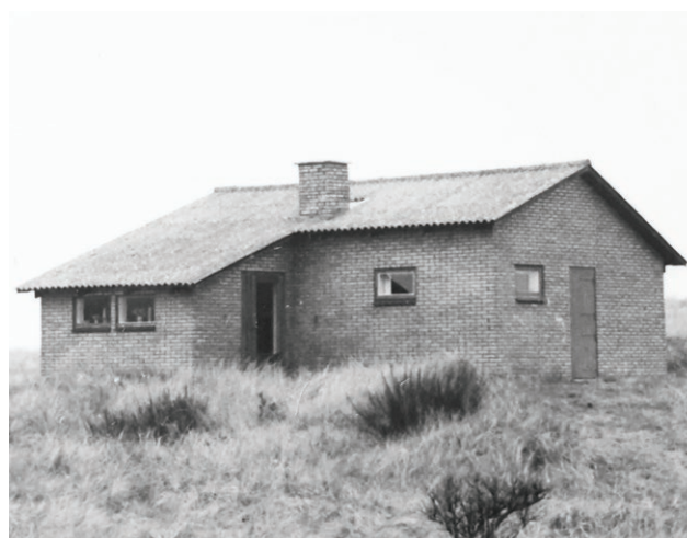
Vestervej 25 (opført 1961, foto 1979) er et godt eksempel på 1960'ernes parcelhus. Dette er et typehus, som ikke har rod i den traditionelle byggeskik. Huset er enkelt, praktisk. Det adskiller sig dog fra de traditionelle huse, da det er opført i gule maskintegl og har tag i bølgeeternit, en lav taghældning med stort udhæng, skorsten midt i tagfladen og nye typer af vinduer og døre.
