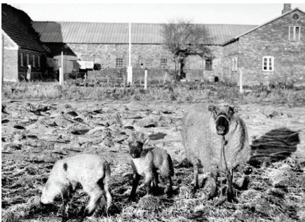
Østre Toftevej 2 (foto ca. starten af 1900-tallet) er et eksempel på en trelænget gård, som danner en u-form. To ud af de tre længer er trempelkonstruktioner. Trempelladen fremstår med en høj facade i blank mur med røde teglsten, tag i pandeplader, et lille udhæng med synlige spærender, murede sålbænke og en gesims ved etageskiftet. Bygningen fremstår med en stor revleport, høje smede- eller støbejernsvinduer med tolv ruder samt et rundt dekorativt støbejernsvindue i gavlens top.
