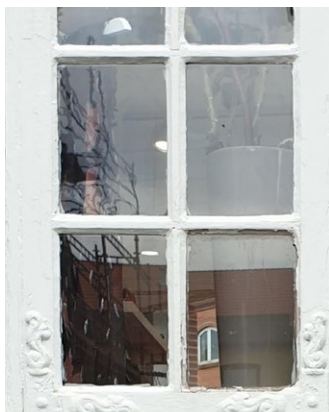
Eksempel på et kittet vindue med etlags-ruder i cylinderglas. Spejlingen af omgivelserne bølger let og giver et spil til overfladen. Når solen brydes af glasset, giver det et varieret lysindfald. Kittede vinduer og gamle glasruder bidrager med liv og variation til facaden.
