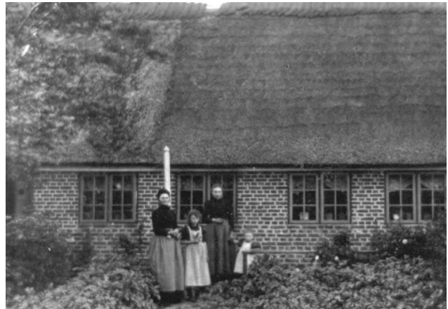
Mandø Byvej 22 (opført 1840, foto slutningen af 1800-tallet) fremstod med torammede vinduer med seks ruder i hver ramme. Lodpost og karm havde oprindeligt en mørk farve, mens ramme og sprosser havde en lysere farve. Denne kombination har ofte været anvendt på Mandø.
