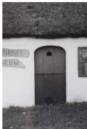
Mandø Byvej 5 (opført 1830, foto 1979) fremstod med en simpel tværdelt revledør med brede planker, rundbuet glug og et muret stik og gesims. Denne type revledør er typisk for stalddørene på Mandø. Over døren anes spor efter et mindre arkengaf.
