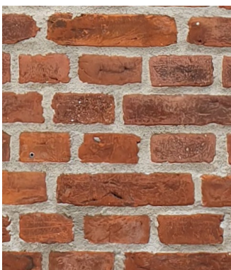
Eksempel på kulbrændte sten udkåret på maskine
