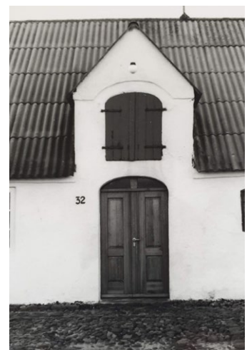
Mandø Byvej 32 (opført 1870, foto 1979) er et eksempel på et traditionelt længehus. Døren er en tofløjet fyldningsdør med to fyldninger og en overramme med to ruder. Døren er monteret på indersiden som ved de ældre traditionelle længehuse og er malet med ådringsteknik (se s. xx).
