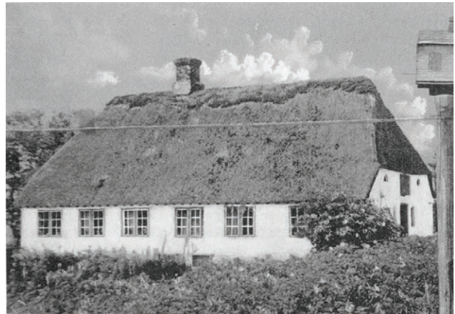
Huset er nedbrændt (opført i 1700-tallet, foto ca. slutningen af 1800-tallet). Bygningen var et af de ældste længehuse på Mandø og fremstod med en lav facadehøjde og et stejlt stråetækt tag med halvvalm. Vinduerne var små torammede med sprosser og seks ruder i hver ramme. Karm og lodpost var malet i en mørk farve, mens ramme og sprosser var malet lyse. Dør og høgab var placeret i gavlen og ikke under en arkengaf. Skorstenen afslører, at huset sandsynligvis blev opført i blank mur og senere blev kalket hvidt. Gesimsen har været en enkel tandsnitsgesims men dekorativt bemalet i en mørk nuance.
