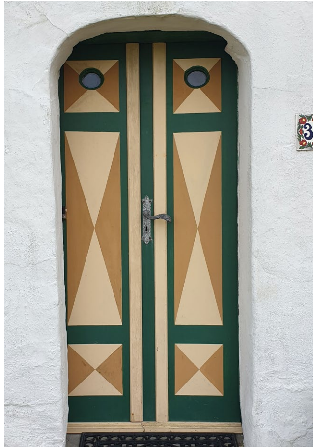
Eksempel på en tofløjet dør på Mandø, med bemalede slaglister fyldningsdekorationer. Bemærk de to glug øverst i døren.
