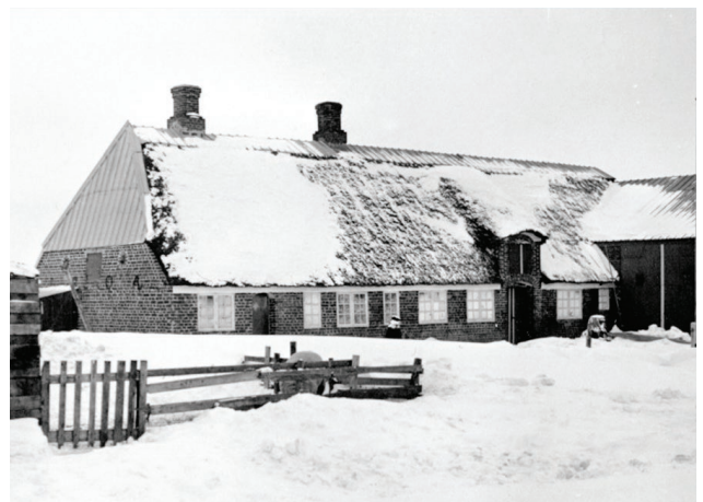
Mandø Kirkevej 4 (foto ca. starten af 1900-tallet) er endnu et eksempel på en trempelkonstruktion, som dette tilfælde er bygget ovenpå resterne af en gammel lade. Trempelladen er en tilbygning til et traditionelt længehus og er særlig unik ved, at man har benyttet 1800-tallets industrielle pandeplader både til tag og til dele af facadebeklædningen. Dette er også en del af kultur- og udviklingshistorien på Mandø.
