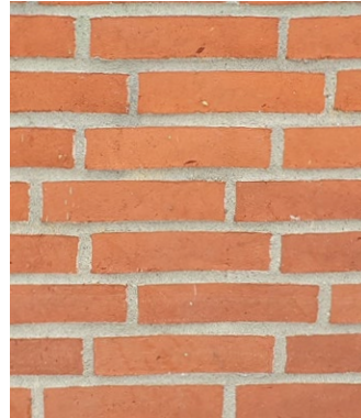
Eksempel på gasbrændte maskinsten
