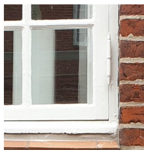
Eksempel på et kittet vindue og hamborghængsler malet med hvid linoliemaling. Materialerne og udformningen giver en lethed og et spil til facadens samlede udtryk.
